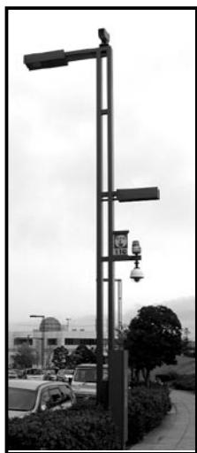
▲写真 1：防犯灯本体
