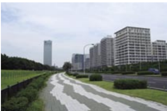
デッキ建設予定地。現在は海浜大通りで遮断されているベイタウンから海へのアクセスが大きく改善され、海沿いの番街はマリリゾートに。
